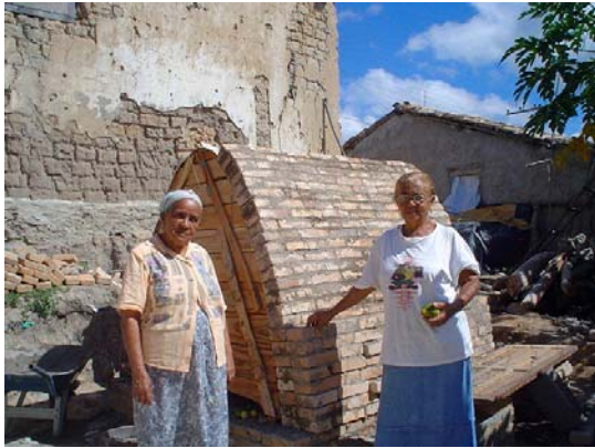
Figura 12. Dona. Isabel Mendes e Da. Iracema visitam o arco catenário em construção. Foto:
