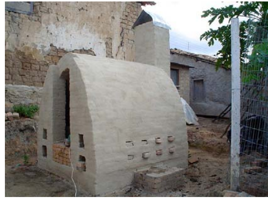
Figura 13. Forno catenário depois de pronto, vendo-se aberturas laterais para oxigenação das fornalhas.
